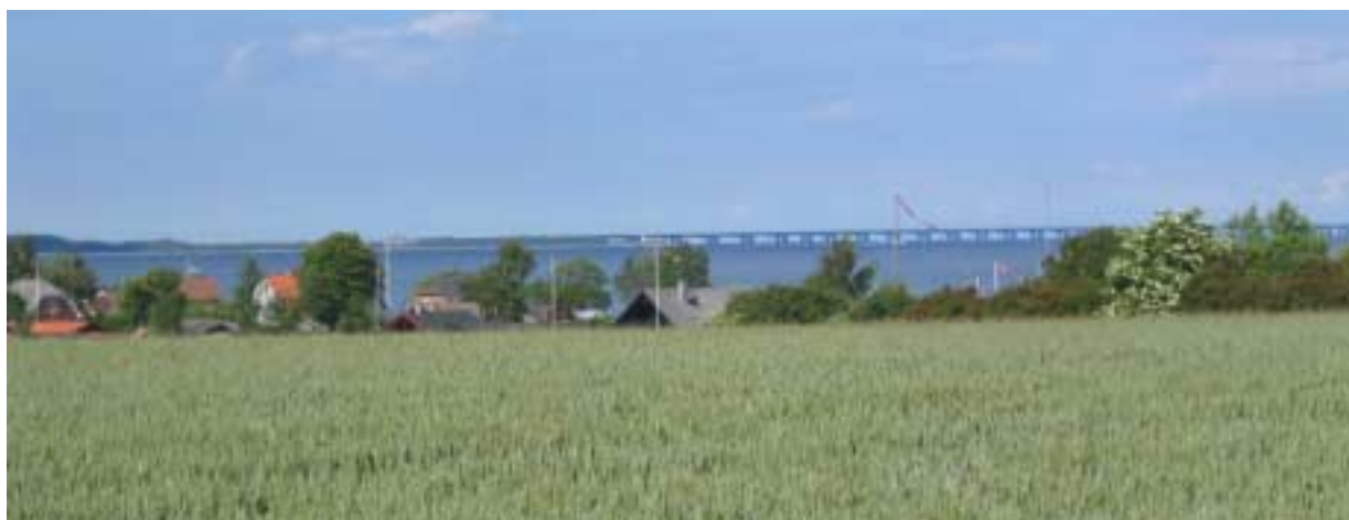
Udsigt til Storebæltsbroen (vestbroen) fra lokalplanområdet
